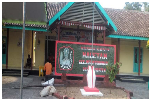
Gambar1 Balai Desa Simbatan
